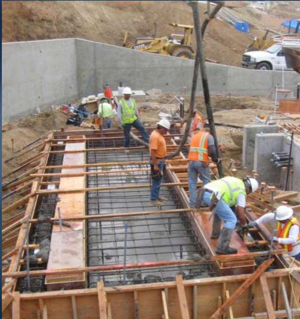
Motor Control Center foundation pour
